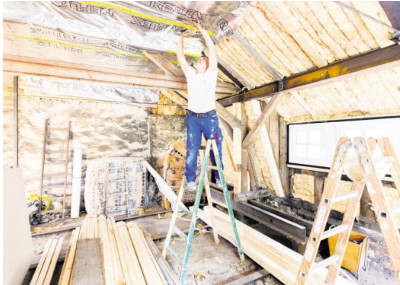
Trockenbauer Dirk Koppenhagen muss sich strecken, um die Folie über die Dämmung zu heften.
